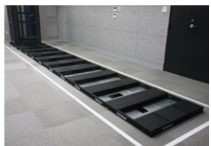
「地震の揺れを最小限に抑える免震装置」
