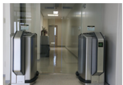
「不審者の入館を防ぐフラッパーゲート」
